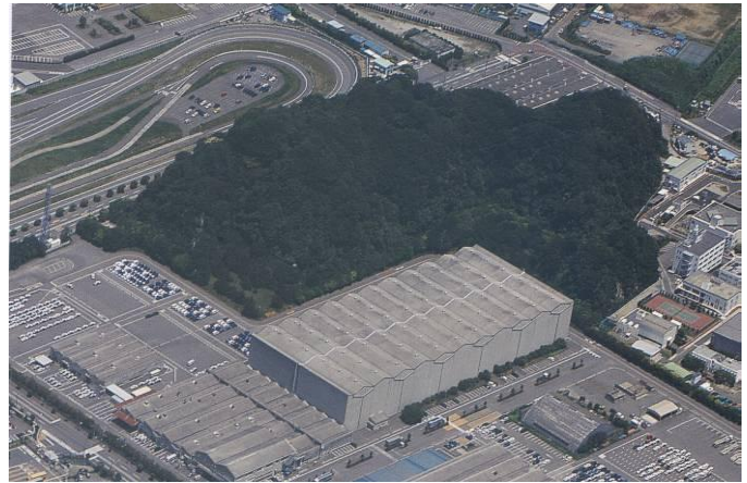
上空から見た夏島『よこすかの文化財』より 右下に見えるのは戦時中の飛行機格納庫
