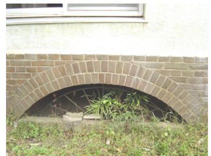
第二火薬本庫の土台部分。
