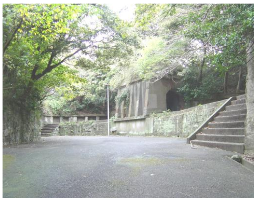
南側から見た第一砲台。
