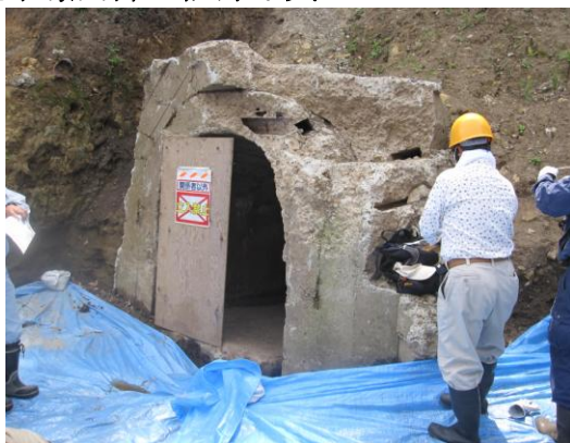
2a入坑部一部破損 断面a-a
