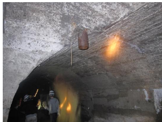
2a坑道2番目交点の天井排気孔鉄パイプ
