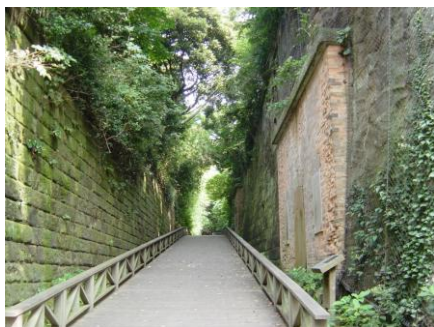
切通し右側レンガ部分兵舎
