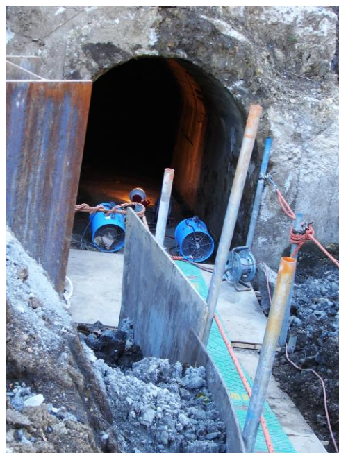
航空本部地下壕入口
