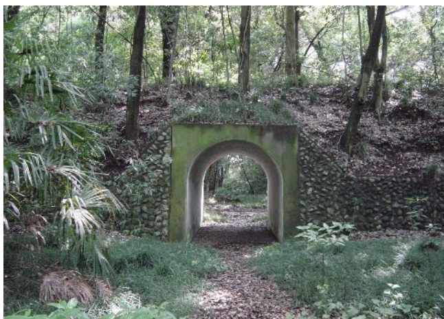
火薬工室・火薬庫は5 m位の土塁に囲まれトンネルを通して出入していた
