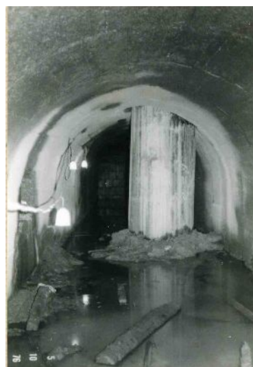
76年10月5日撮影 1mの直径鉄筋コンクリート抗柱が打ち込まれた。
