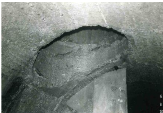
76年9月6日撮影 地下壕の天井はダイヤモンドカッターで大きな穴が貫通された。
