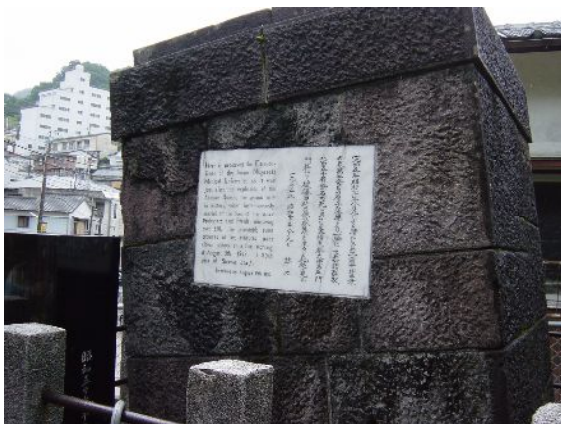
爆心地東 600m長崎医科大学正門門柱 (7 t) が爆風で前方に 9cm 傾き隙間を飛んできた砂礫が埋めた
