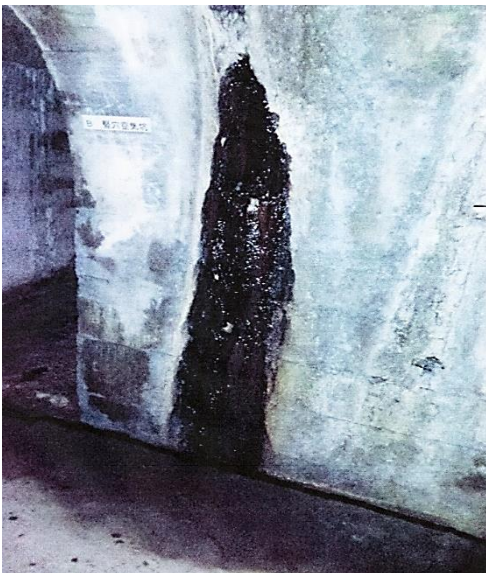
日吉地下壕内の地下水漏出 （竪穴空気坑横）
