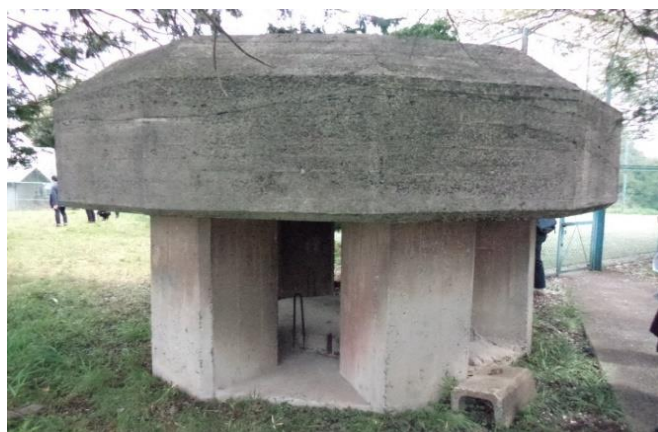
チャペル近くの堅穴空気坑地上部分 (寄宿舍前と同型)
