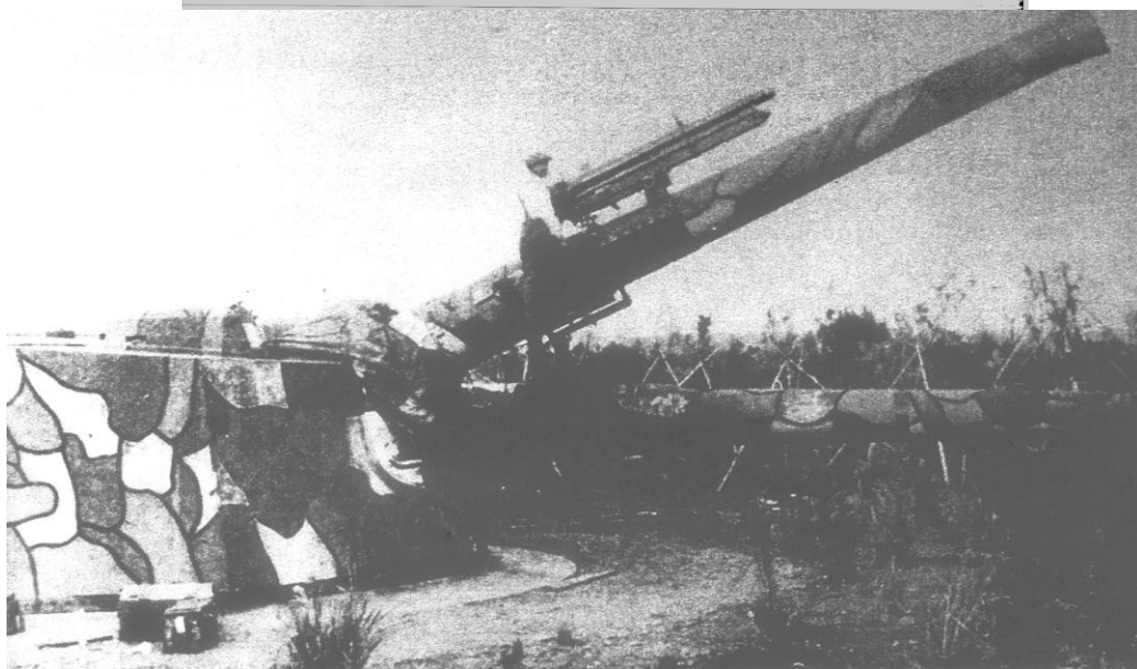
城ヶ島砲台に設置された 45 口径 25 cm カノン砲塔保台。もとは戦艦「安芸」の副砲塔。 (金沢 清氏提供)
